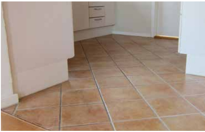
Det originale gulv inden inden renovering
