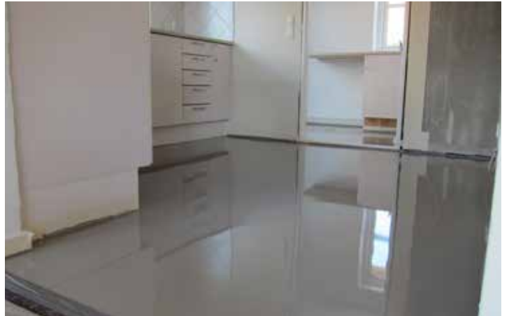
Til denne opgave valgte man en flydende lydæmpende måtte. Dette er valgfrit.
