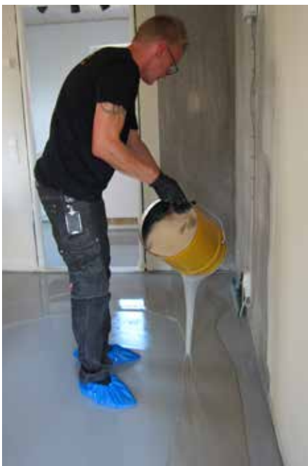
Efter priming blev gulvet skrubespartlet, så fugerne blev plane
