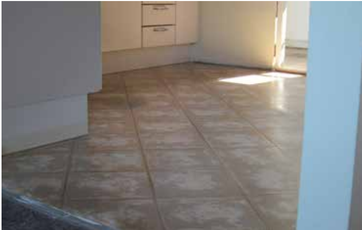
Efter priming blev gulvet skrubespartlet, så fugerne blev plane
